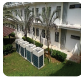
Penggantian sistem hawa dingin ( Central Unit , VRV System dan Split Unit )
