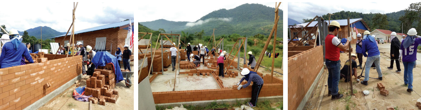
Projek Program Perintis MyBNHome iaitu pembinaan Perumahan Orang Asli, Ulu Slim, Perak
